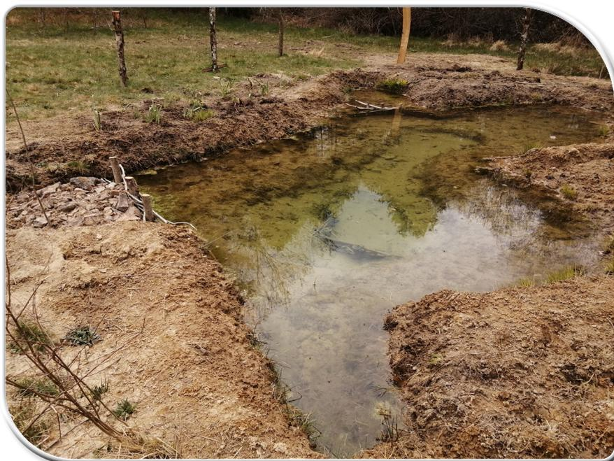
D'une superficie d'environ 20m<sup>2</sup>, elle a été creusée de façon non ovoïde, en zone humide, sur trois strates allant de 50 cm à 120 cm de profondeur. Certaines berges ont été renforcées avec du bois afin qu'elles ne s'écroulent pas et d'autres, avec des pierres, pour permettre aux animaux de venir s'y abreuver sans casser les berges. Des barrières seront installées autour pour des raisons de sécurité.
